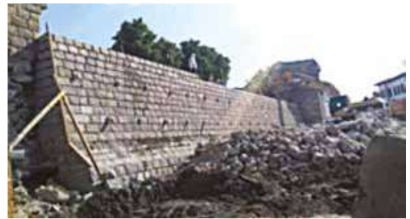
Şekil 15 Men Tapınağı'nın yeni duvarı !
